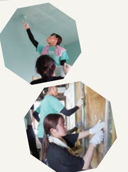
学生による リノベーション作業
